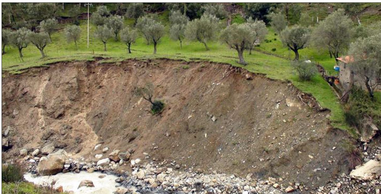
Alcara Li Fusi - Uliveto in prossimità di una frana causata dal Torrente Rosmarino
